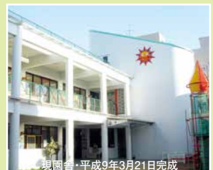
現園舎・平成9年3月21日完成
